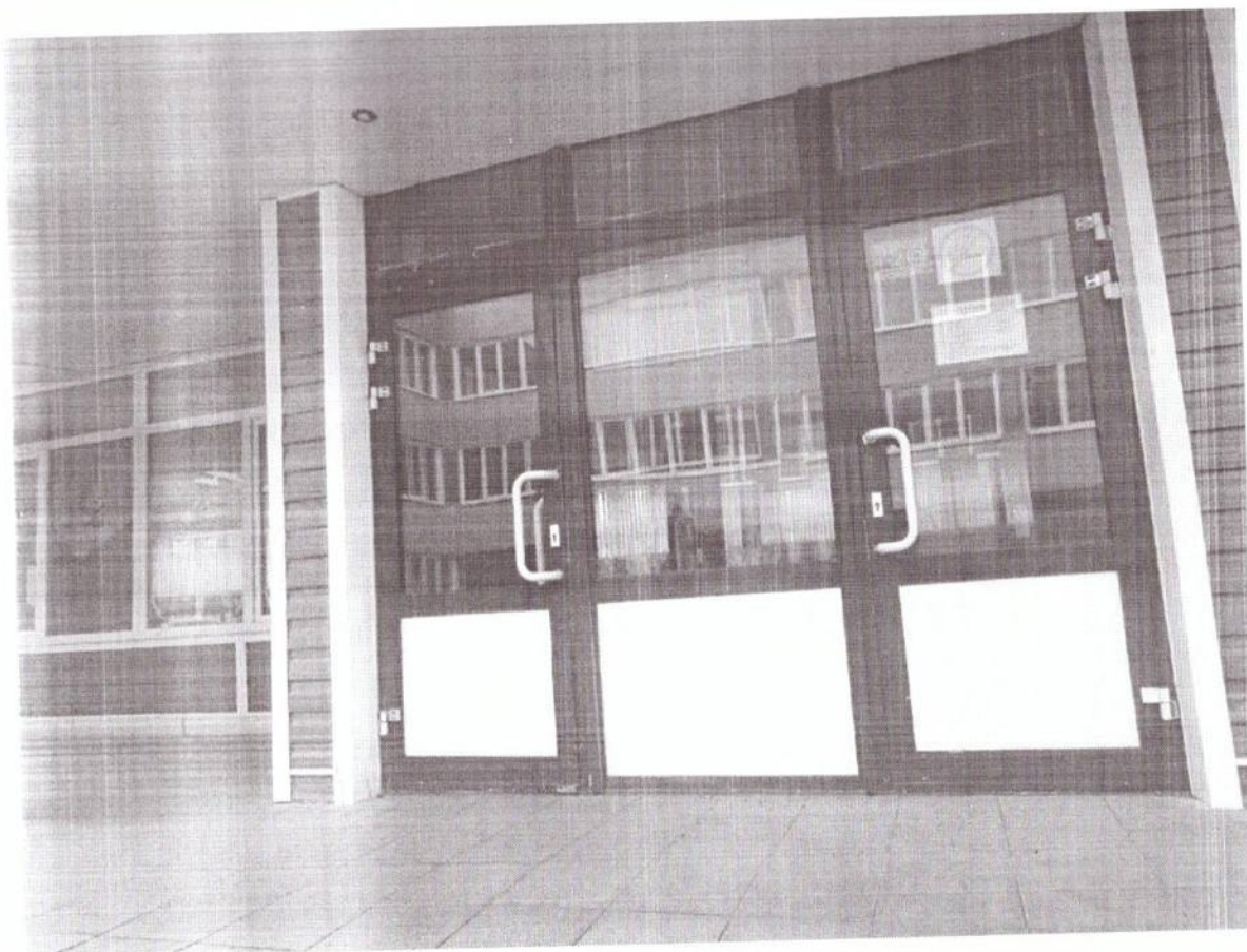
Фото 15. Входная площадка перед дверью
